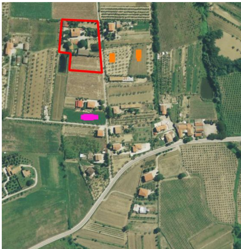
Vista satellitare, in rosso la zona oggetto di variante, in arancione fabbricati in corso di costruzione, in magenta fabbricati di recente costruzione.
